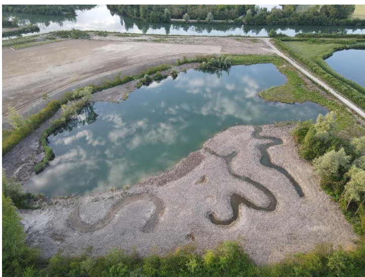
Juin 2022 – Sur le site Pilote Graven, travaux en cours avec la création des chenaux et la reprise des berges,
