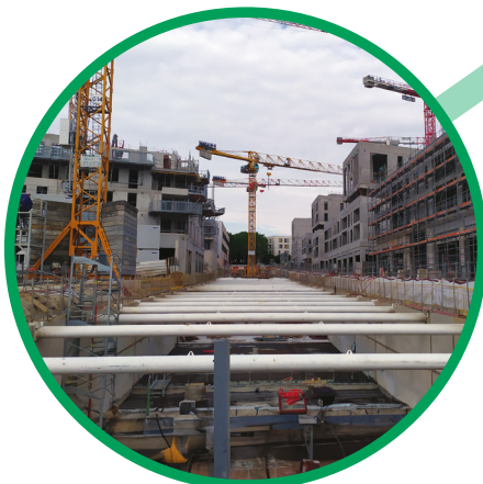
En 2023, travaux en cours du nouveau « chemin central ».
