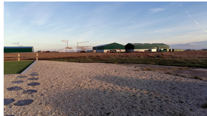
Chantier TSF, constructions autorisées par un permis de construire précaire octroyé le 29/09/2023 © Jane Buisson
