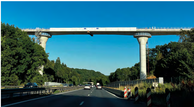
Vue du viaduc en construction de ligne 18 du Grand Paris Express, juillet 2022
