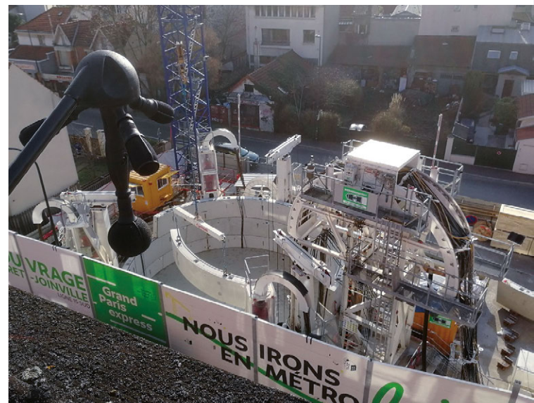
Le dispositif « Méduse » pour voir le bruit sur un chantier de la future ligne 15 Sud à Malakoff (92) © Bruitparif.
