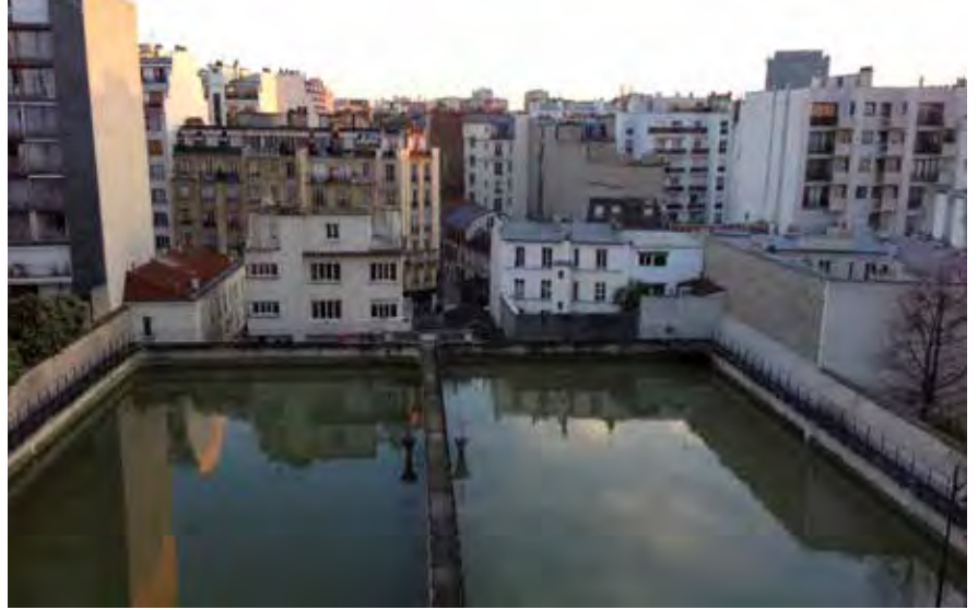
Réservoir de Grenelle rempli d'eau - Paris 15 e © FNE Ile-de-France
