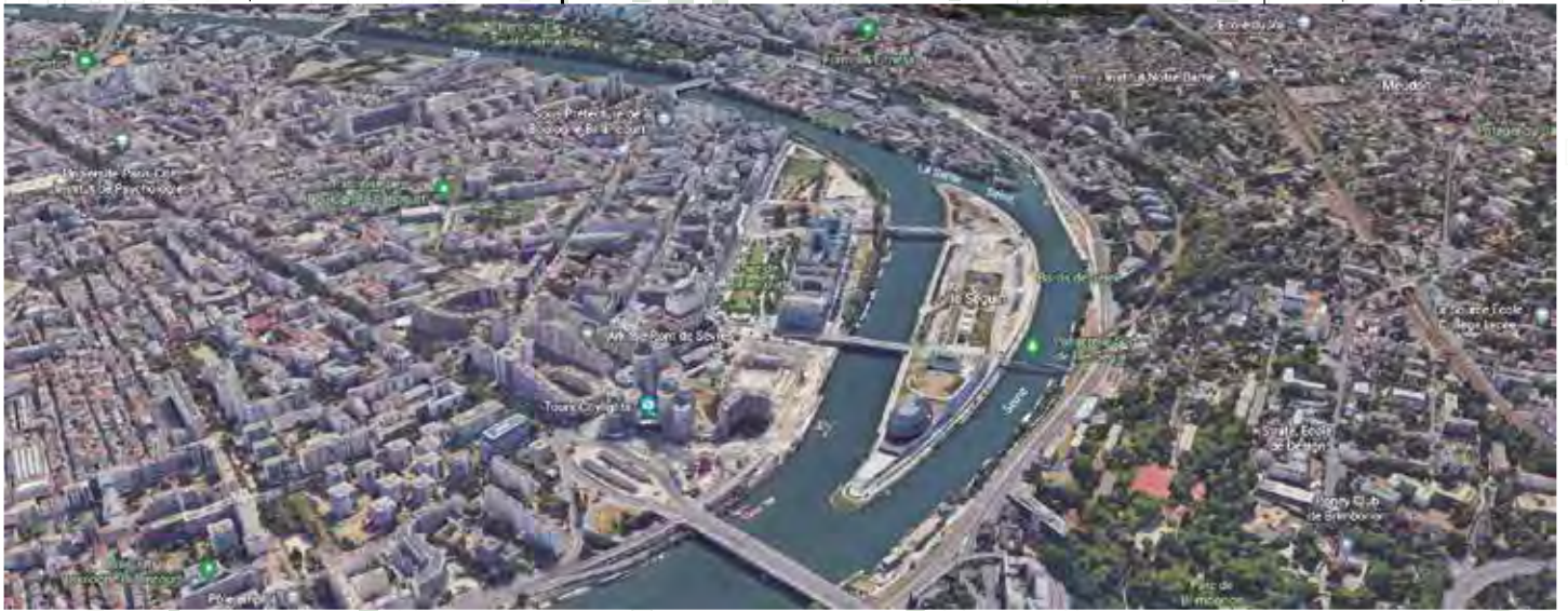
Photo des berges à l'île de Monsieur et les berges bétonnées de l'île Seguin
