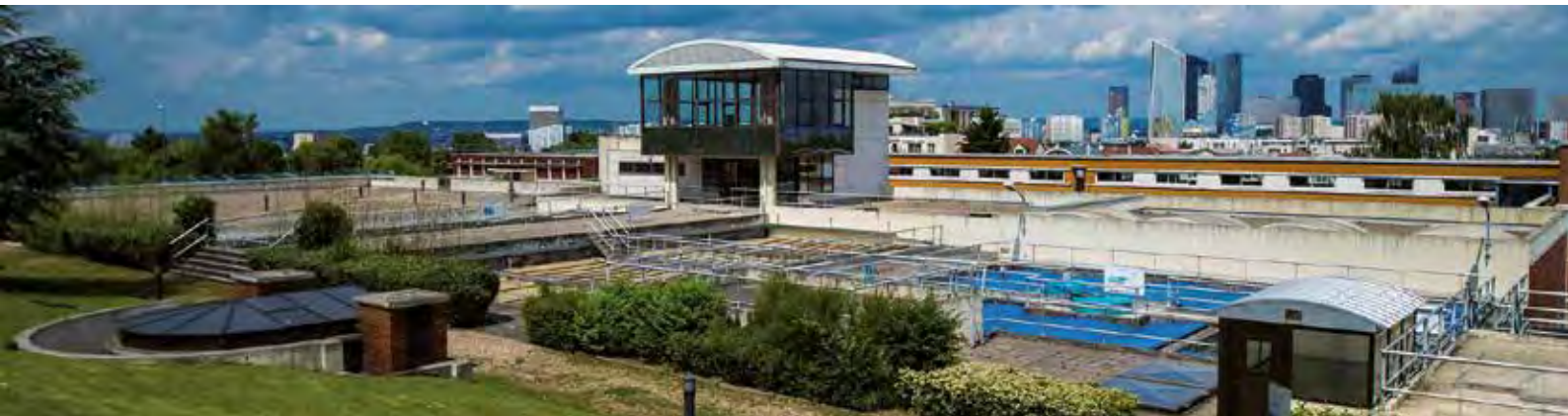
Usine de potabilisation de l'eau du Mont Valérien © Suez
