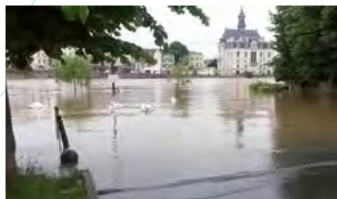
Crue de la Seine à Corbeil-Essonnes - Juin 2016 © Jean-Pierre Moulin
