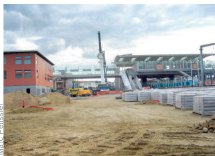
RER Massy, Travaux été 2010
