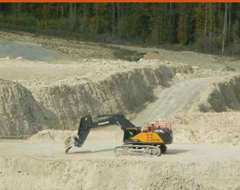
Carrière de gypse à ciel ouvert
